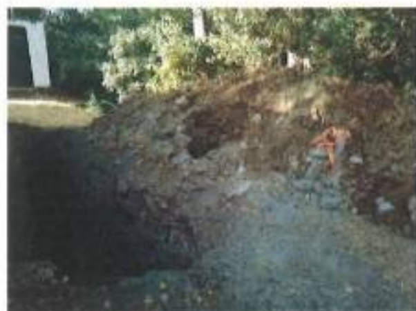
Obras de reparación de atascos en la red de saneamiento
